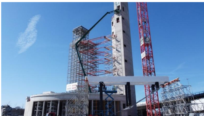
Abbildung 6: Montagevorbereitungen Quelle: Vivas
