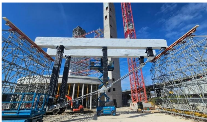
Abbildung 4: Vormontage der unterspannten Träger Quelle: Vivas
