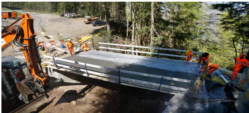
Abb. 4: Fruttli-Brücke, die fertig gegossene Brückenplatte.
