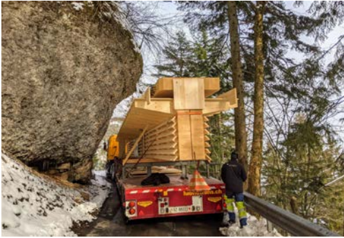
Abb. 7: Transport der drei BSH-Träger der Rigiaa-Brücke. Die Schalung für die auskragende Brückenplatte ist bereits an den äusseren Trägern vormontiert.
