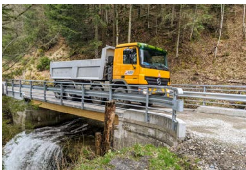
Abb. 3: Ansicht der Fruttli-Brücke kurz nach dem Bau.
